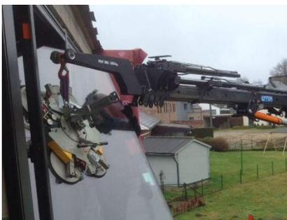
La suspension abaissée située au centre du palonnier permet la pose sous "casquette" ou dans les espaces restreints. Sur modèles manuels
